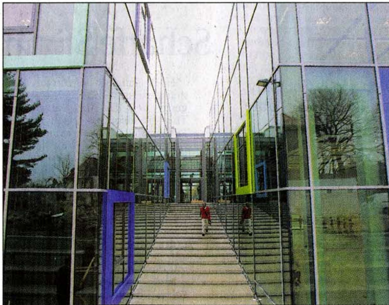
Die Treppe zwischen den in Glas gefassten Tanzsälen führt zukünftig in den gestalteten Außenbereich.
