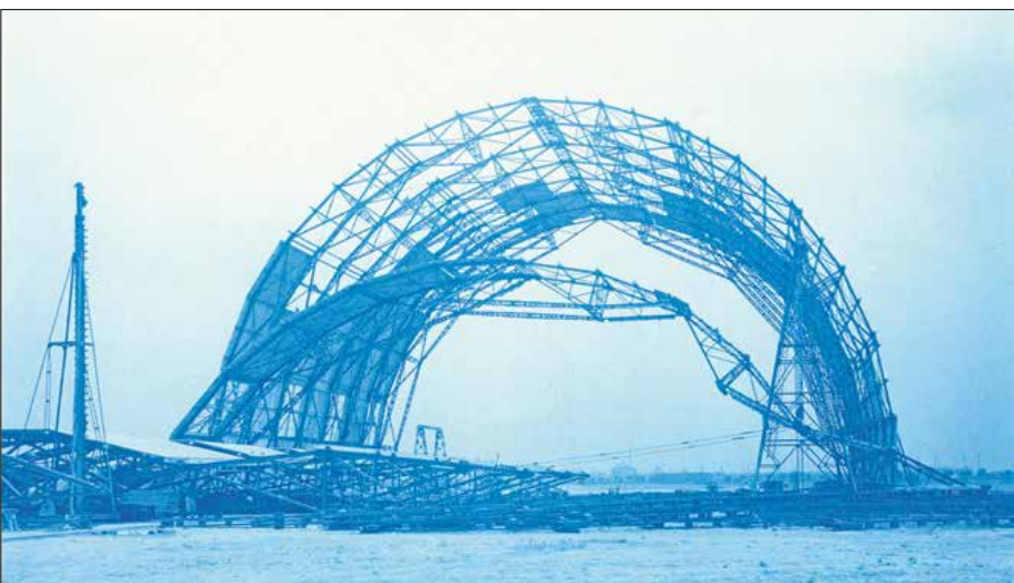
Die städtische Luftschiffhalle Dresden im Bau, Juli 1913.
