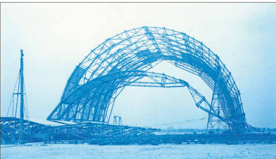
Die städtische Luftschiffhalle Dresden im Bau, Juli 1913.
