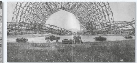
Städtische Luftschiffhalle Dresden nach Sprengung der Kuppeldreh-tore, August 1921 (Sprengstoff- und Munitionsgesellschaft m.b.H. Leutersdorf, in: „Berliner Illustrierte Zeitung“ vom 21. August 1921)
