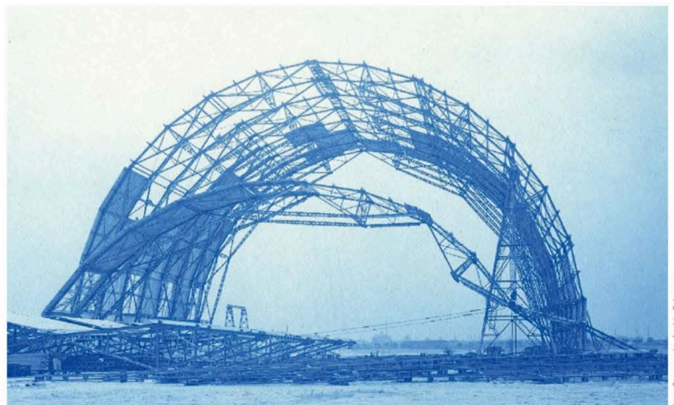
Bild 2 Die städtische Luftschiffhalle Dresden im Bau, Sommer 1913
