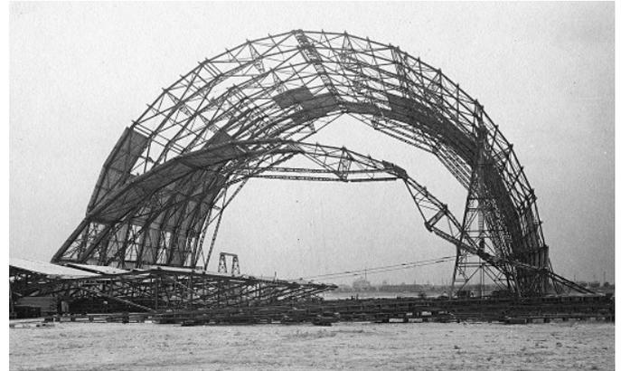
Bild 4. Aufrichtung des fünften Doppelbinders auf der Luftschiffhallenbaustelle in Dresden-Kaditz, Sommer 1913 (Aufnahme: Steffens & Nölle AG, Berlin-Tempelhof)
